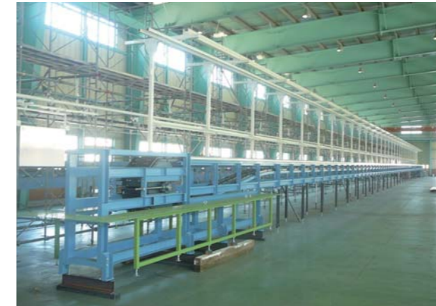
エンジン組立スラットコンベヤ (機長120m)
